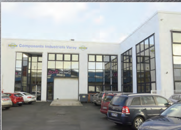
Bâtiment principal / Head office
